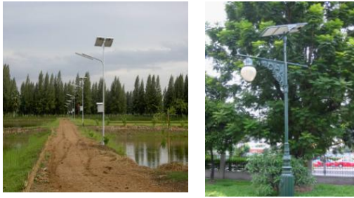
ระบบไฟส่องสว่างสาธารณะพลังงานแสงอาทิตย์
